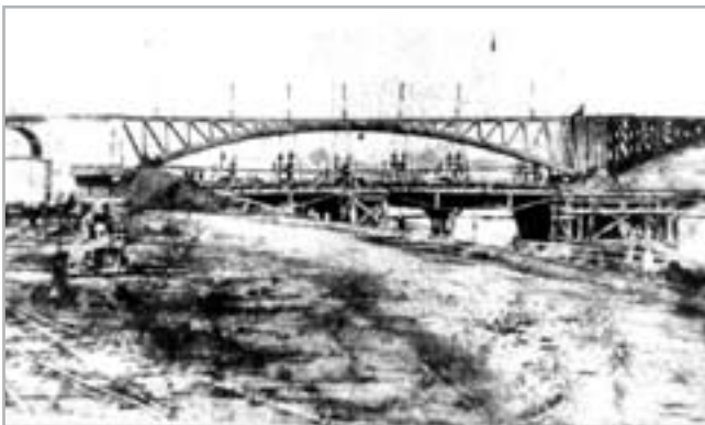
3. ÁBRA AZ ÉPÜLŐ VASÚTI HÍD ELŐTT LÁTHATÓ AZ IDEIGLENES MUNKAHÍD EGY RÉSE. REPRO GÁDZSER JÓZSEF GYŰJTEMÉNYÉBŐL
